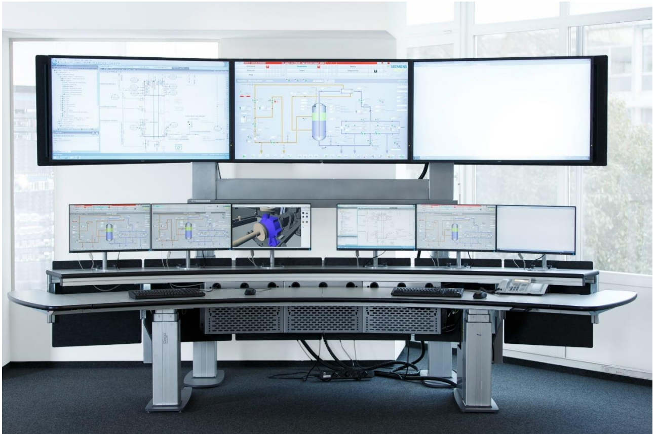
Hình 7. SIMATIC PCS 7 là hệ thống “tự động hóa quá trình” chủ lực của Siemens
