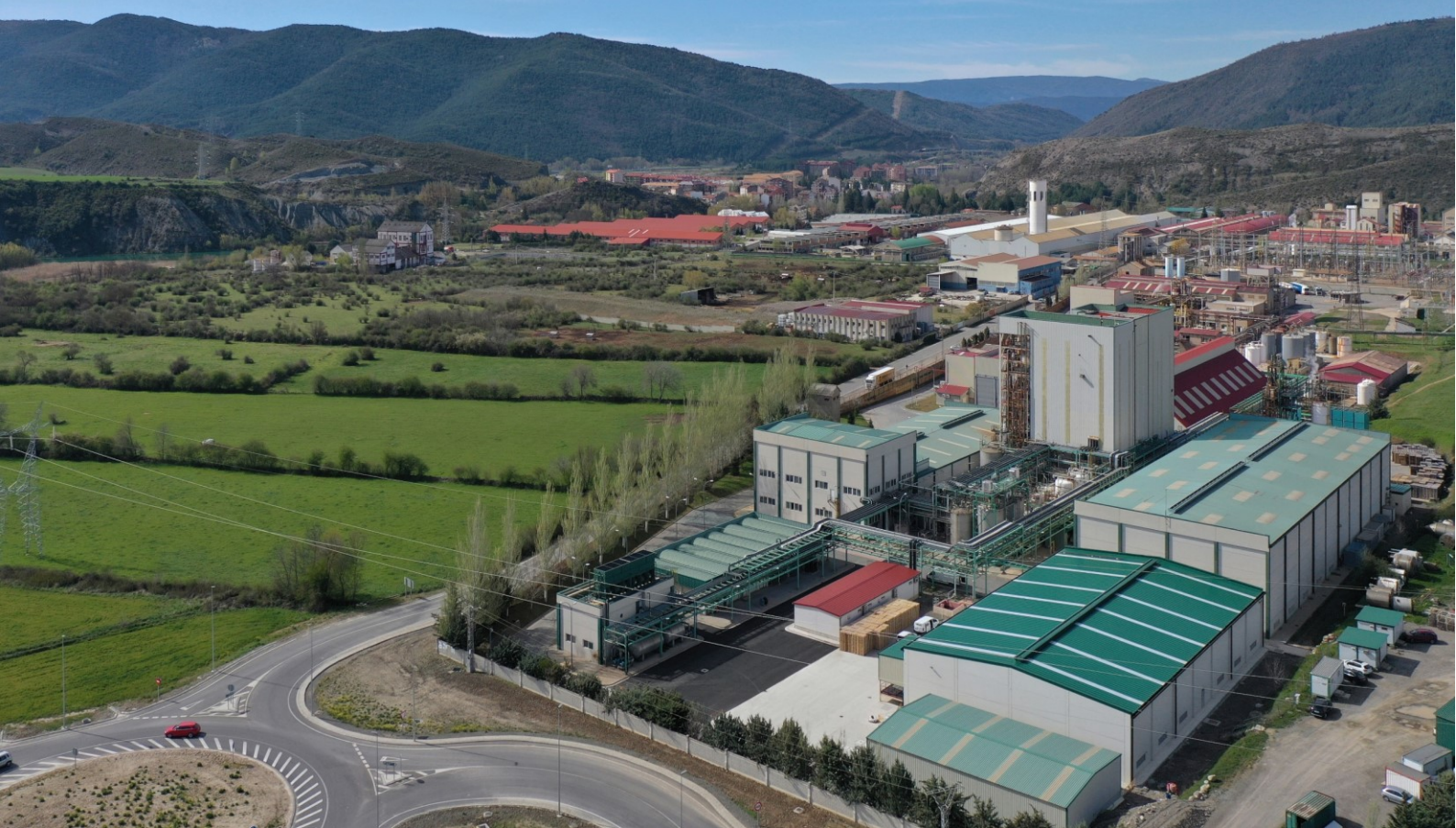
Alles im grünen Bereich in der Ercros-Chemieanlage Sabiñánigo
