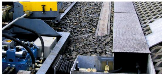
Aktiver Gewässerschutz durch Verlegung in öldichten Kanälen
