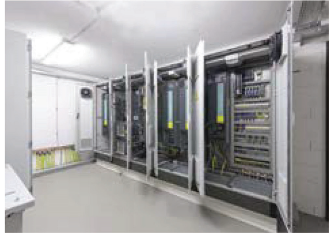
LA TOPOLOGÍA DE MÚLTIPLES EJES DE SINAMICS S120, CAPAZ DE LA RECUPERACIÓN DE ENERGÍA, PERMITE QUE LOS MANDOS INDIVIDUALES INTERCAMBIEN ENERGÍA A TRAVÉS DEL ENLACE DE CC.
