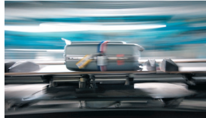
Flughafen Zürich AG, Gepäcksortieranlage Zürich
