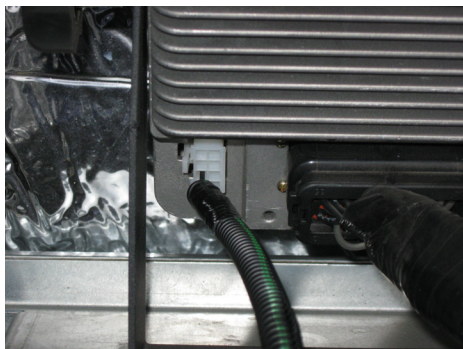
Figura 2.2 - Arnés instalado en el controlador.
