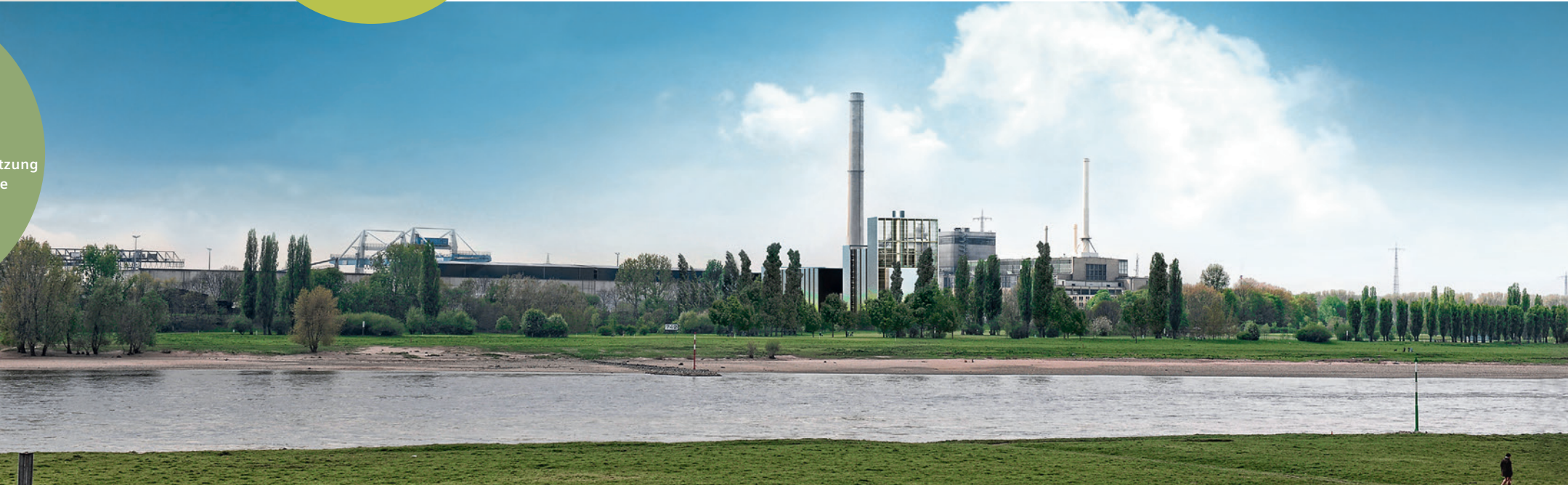
Größte Leistung Das Herzstück unseres Kraftwerks ist eine Gasturbine, die so viel leistet wie 22 Jumbojet-Triebwerke. Gemeinsam mit der nachgeschalteten Dampfturbine sorgt sie für 595 MW e , eine Leistungsstärke, die kein anderes GuD-Kraftwerk mit Abwärmeenergie weltweit erreicht.
