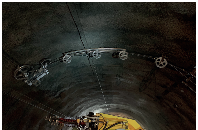
Bild 13: Überwachte Nachspannvorrichtung der beidseitig überwachten Nachspannung im Tunnel (Foto: Siemens Mobility/RhB).
