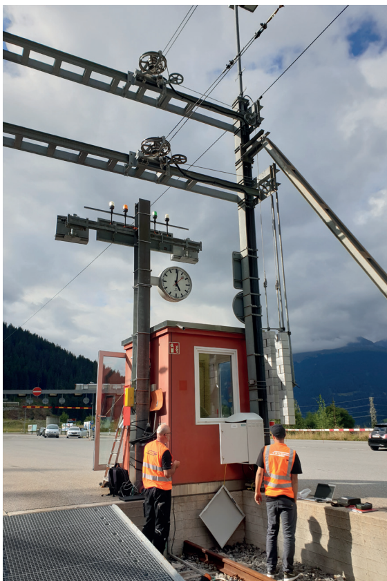
Bild 13: Überwachte Nachspannvorrichtung der beidseitig überwachten Nachspannung im Tunnel (Foto: Siemens Mobility/RhB).
