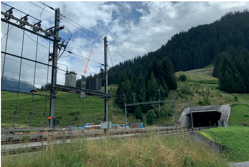
Bild 14: Blick auf den Schaltposten mit integriertem, aber primärseitig nicht angeschlossenem Lastschalter E16 ( Pfeil ) und Tunnelportal im Bereich Selfranga der Vereina-Linie der RhB.
