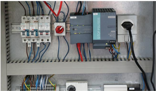
Starkes Team im Schaltschrank: Das Wägemodul Siwarex WP231 wird bei Cargologic ohne Simatic Controller eingesetzt. Die Standardstromversorgung Sitop smart überzeugt bei kompakter Bauform mit einem hohen Wirkungsgrad
