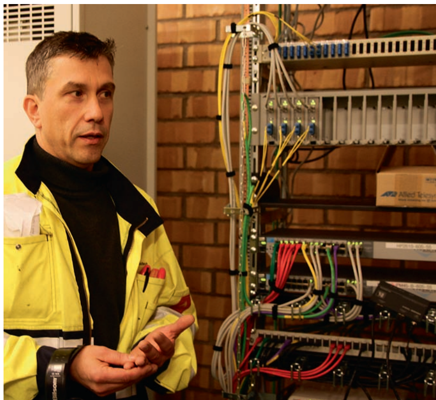
– Om man har blandat ABB och Siemens i en anläggning är kommunikationsmodulen perfekt, säger Bert-Åke Holmsten, teknisk specialist inom el och styr på SCA Ortviken.
