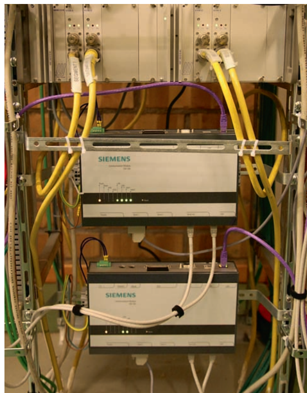
Med en gateway, CM104, kan man kommunicera direkt mellan Simatic PCS 7 och ABB-systemet via Ethernet.
