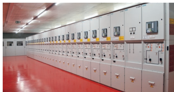
(à g.): Installation moyenne tension 11.6 kV (24 kV) avec SIPROTEC 5, (à d.): Transformateur de puissance 25 MVA (11,6/132 kV) avec refroidissement huile-eau
