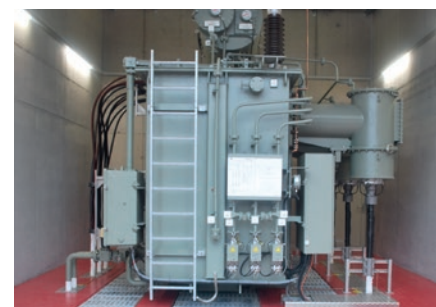
(à g.): Installation moyenne tension 11.6 kV (24 kV) avec SIPROTEC 5, (à d.): Transformateur de puissance 25 MVA (11,6/132 kV) avec refroidissement huile-eau
