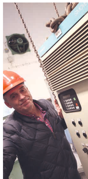
Slutbesiktning av den moderniserade driften med funktionstestning. En av två 1LA6-motorer i bakgrunden.
