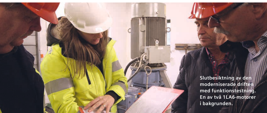
Jesper Ljungberg, servicetekniker på One Nordic, Lennart Holmer, produktspecialist inom drivteknik på Siemens, Ronny Eriksson, Service Sales Specialist på Siemens, Roine Fransson, anläggningsansvarig på Uniper, och Åsa Magnemark, projektledare på Uniper.
