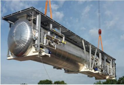
Schwebender Koloss: Im Separator wird nach der Installation „rohes“ Nassöl in die Wasser-, Gas- und Ölphasen getrennt.
