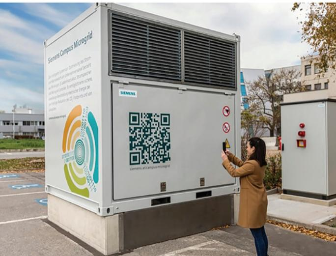
Der 500-kWh-Batteriespeicher hilft, die Nutzung der lokal erzeugten Energie zu maximieren.
