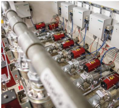
Integration der Smart Discharge Unit ins Löschesystem
