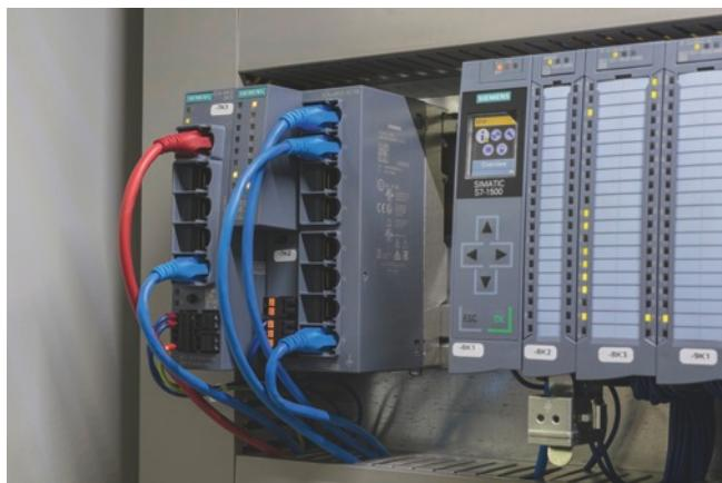
Kompakte Automatisierungstechnik optimal im Schaltschrank integriert: Das Security Modul SCALANCE S615 zusammen mit dem Industrial Ethernet managed Switch SCALANCE XC108 und dem SIMATIC-Controller S7-1500
