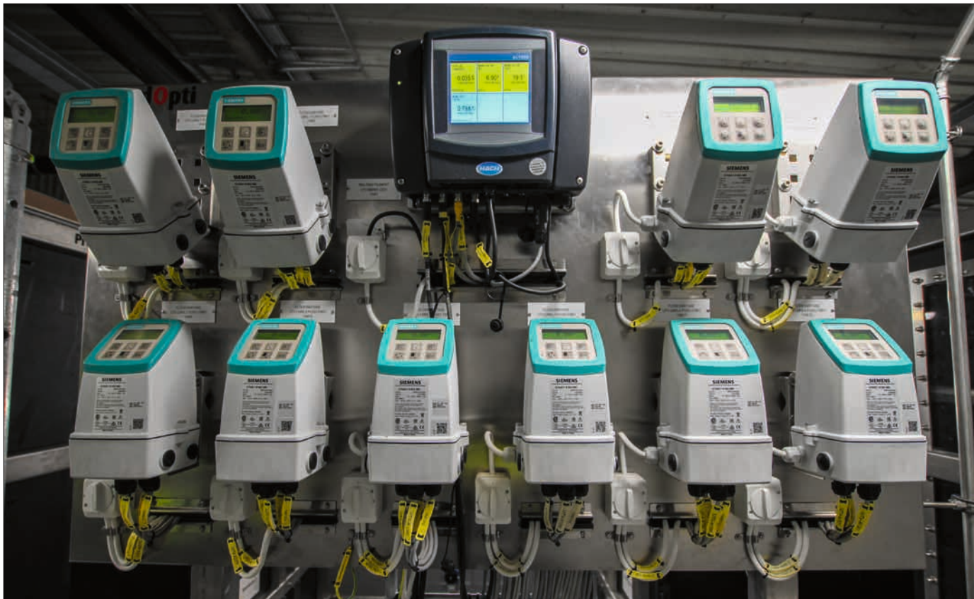
Anläggningen är full av processinstrument från Siemens.
