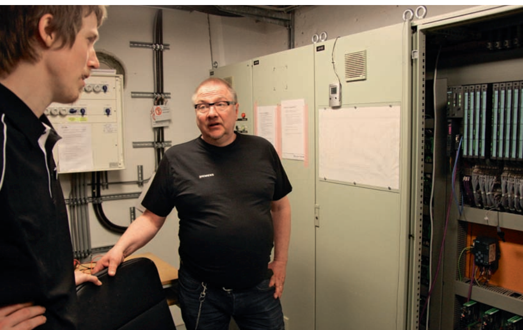
SAGOGUBBAR: Oscar Canow, tågtekniker och anläggningsansvarig på Junibacken, och Bo Steen, serviceingenjör på Siemens, säkerställer att Sagotåget rullar som det ska.
