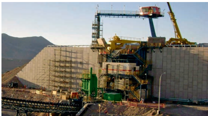
UNDERHÅLL. Den nya malmkrossen och transportbandet i Codelcos dagbrott Radomiro Tomic, där Siemens tar ansvar för underhållsarbetet.
