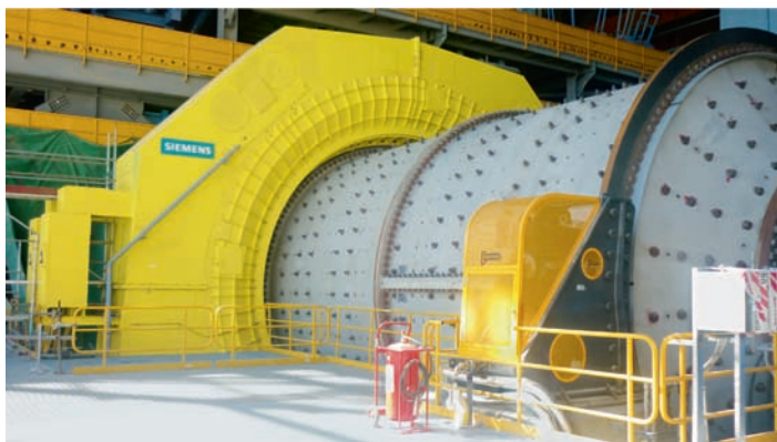
ÖKAD KAPACITET. Redan 1999 installerade Siemens två kvarnar i Los Pelambres, vilket utökades med två nya kvarnar 2010.
