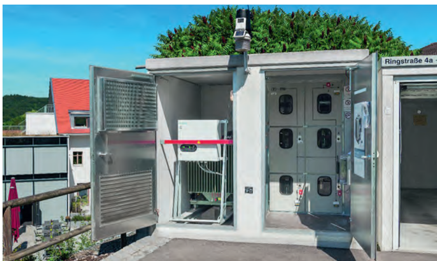
От такива местни трансформаторни станции електрическата енергия се пренася по мрежата за ниско напрежение до домакинствата
