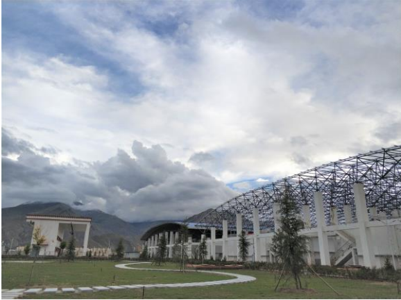
建成后，纳金水厂将是全球高原地区规模最大的地表水厂。
