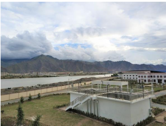
在位于拉萨河畔的纳金水厂泵房内，由西门子提供的 SIMOTICS A-compact plus 高压异步电机将为取水工程提供有力支持。
