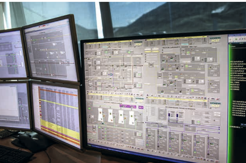
Styrning och övervakning från kontrollrummet med Siemens processkontrollsystem.
