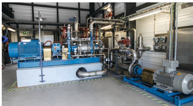
Kompressorrummet med motorer och processinstrument från Siemens, där vattnet och gaserna pumpas till "sodamaskinen", skrubberkolonnen.
