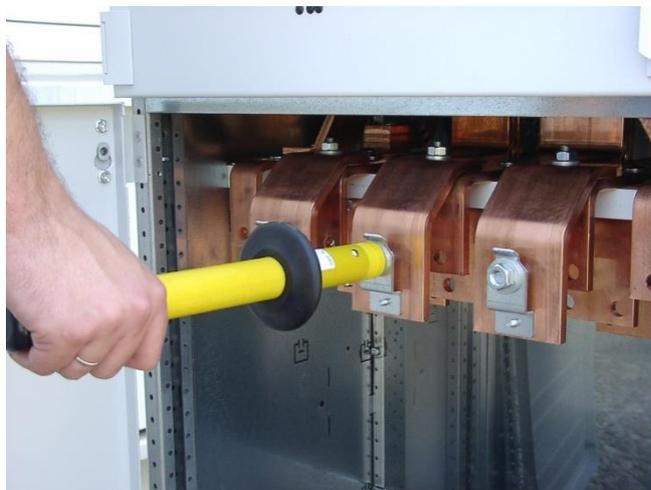
Figura 5: Tuerca L3 aflojada, aflojar tuerca L2
