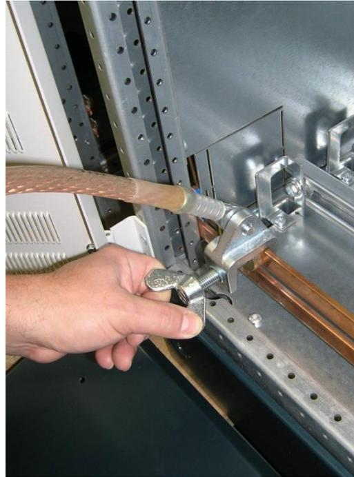
Figura 8: Apretar el tornillo de fijación
