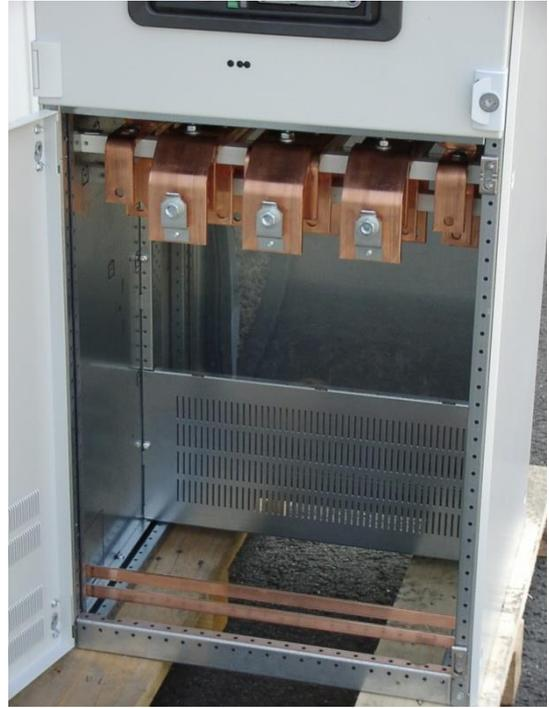
Figura 4: Cable desde abajo, compartimento de cables abierto
