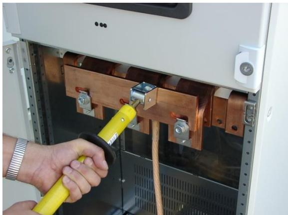
Fig. 11 Alinear las perforaciones de la barra con los pernos.
