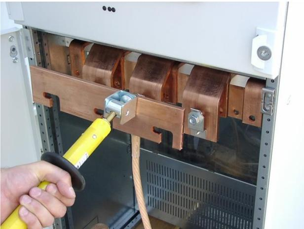
Figura 9: Ajuste del ángulo más apropiado para manejar la barra con la varilla de aislamiento
