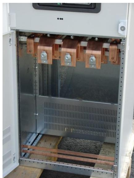
Figura 6: Tuercas aflojadas antes de colocar la barra cortocircuitadora
