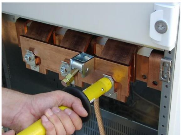
Figura 12: Apretar manualmente las tuercas de los conductores de fase con la varilla de aislamiento
