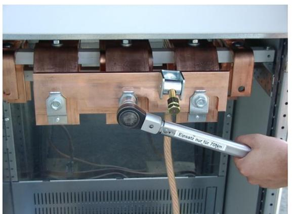
Figura 14: Apretar las tuercas de los conductores de fase con la llave dinamométrica con 70 Nm
