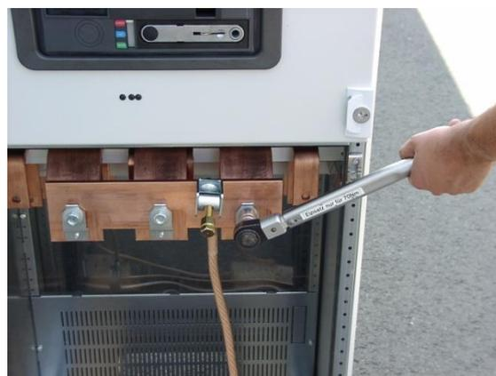
Figura 15: Apretar la tuerca L3 con la llave dinamométrica con 70 Nm
