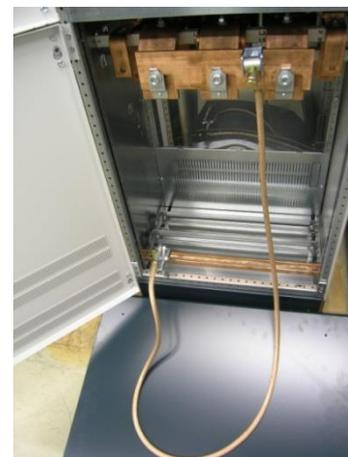
Figura 13: Tuercas apretadas con la varilla de aislamiento
