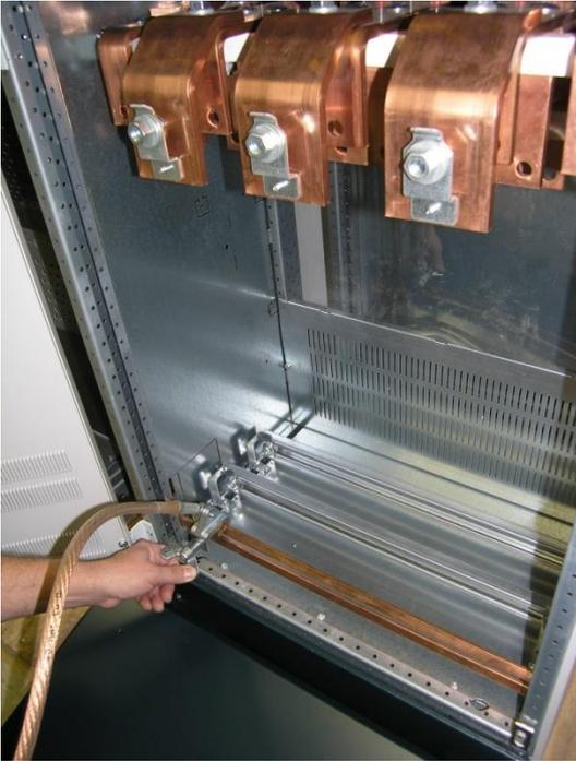
Figura 7: Conectar las abrazaderas de puesta a tierra en PE(N).
