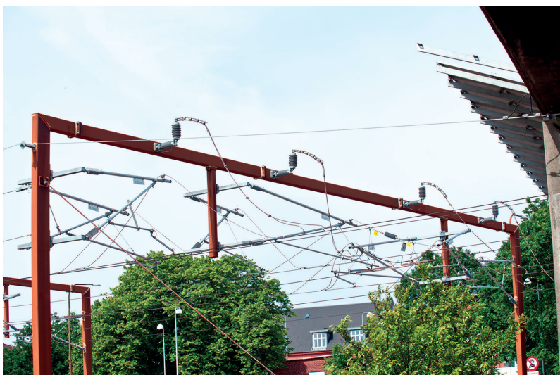
Bild 5: Frodesgard Brücke mit Ableitersystem.
