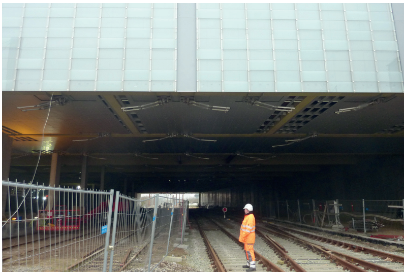
Bild 4: Bauzustand am Shoppingcenter Esbjerg.
