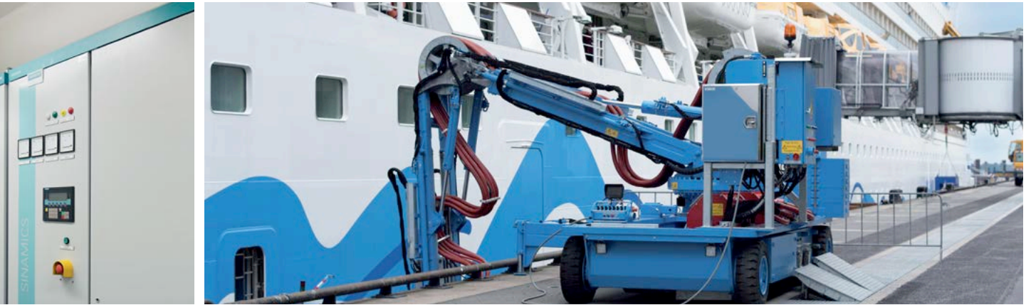
Schnelle und einfache Verbindung zum Schiff durch das Kabelzuführungssystem
