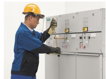
Abbildung 1: Wartungsarbeiten während des Anlagenbetriebs
